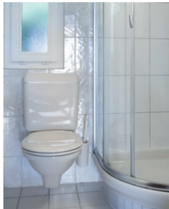
VORHER Einbausituation mit Aufputzspülkasten
