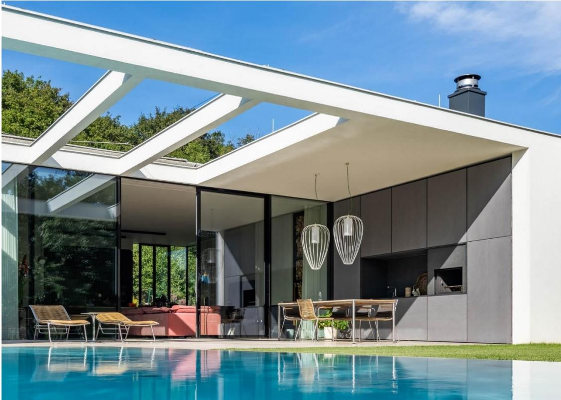
Die **sologlas**-Hebeschiebetüre der **manufaktur matauschk** besteht aus **rahmenlosen**, flächenbündigen Isolierglaselementen. Im emaillierten Randbereich des Isolierglases werden alle funktionellen wie auch abdichtenden Teile eingebaut. Der Übergang ist schwellenlos und hat keine versenkten Laufschiene. Die Fixverglasungen sind rahmenlos.
