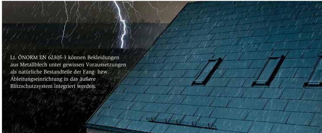
Lt. ÖNORM EN 62305-3 können Bekleidungen aus Metallblech unter gewissen Voraussetzungen als natürliche Bestandteile der Fang- bzw. Ableitungseinrichtung in das äußere Blitzschutzsystem integriert werden.
